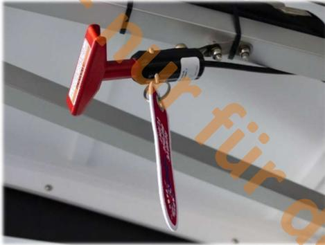
Abbildung 7: Auslösegriff mit Sicherheitspin
